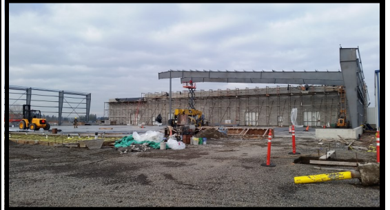
El primer par de vigas para el techo. La pared de bloques en el fondo ya esta completa.
